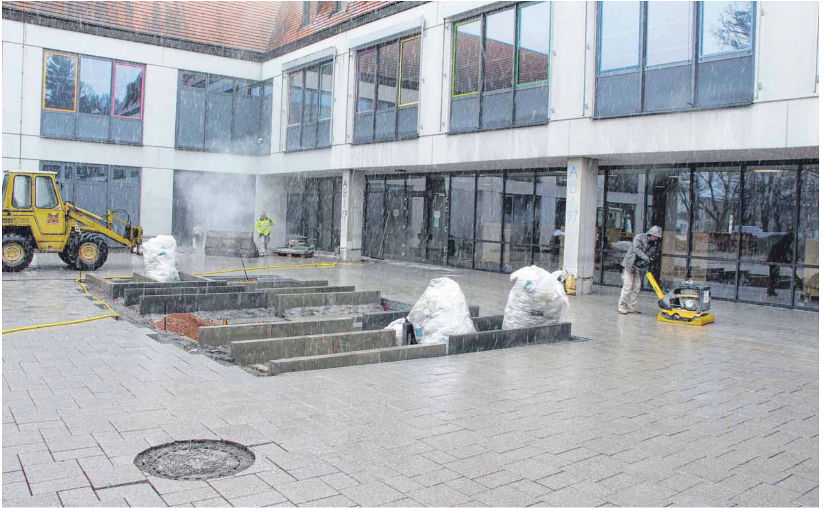
Auf dem rückwärtigen Schulhof des Salvatorkollegs ist der alte Belag abgetragen, die neuen Pflastersteine werden nun verlegt.
