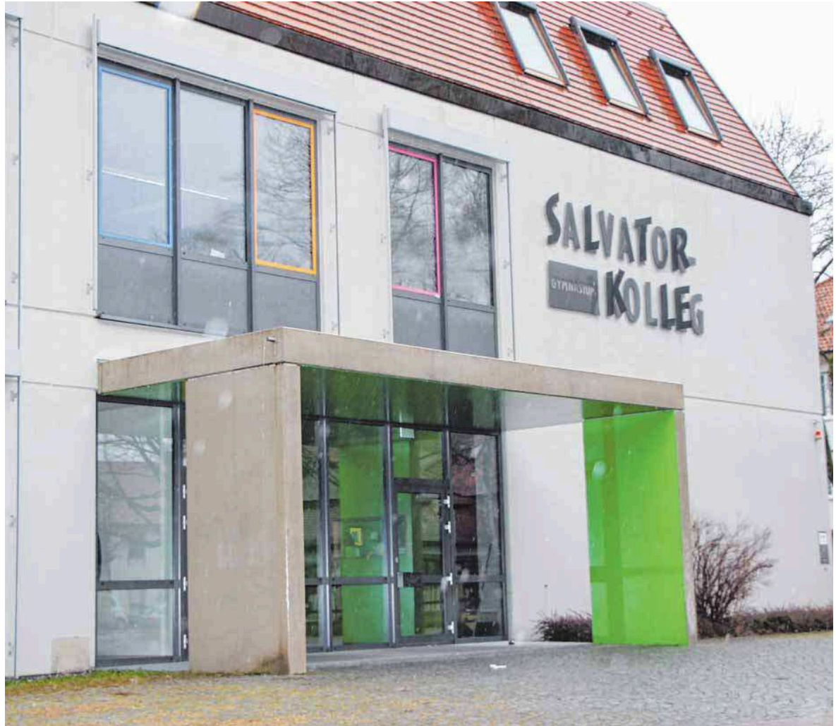
Kann bei einem Tag der offenen Tür besichtigt werden: das umgebaute Salvatorkolleg.
